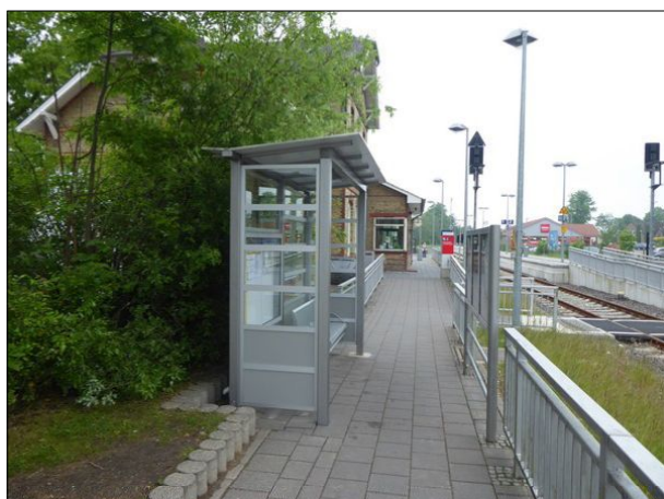
Abbildung 1: Rund zwei Jahre nach Schließung des Warterraums gibt es in Sörup wieder einen Wetterschutz. Am Bahnsteigzugang wurde ein kleiner Unterstand errichtet.
