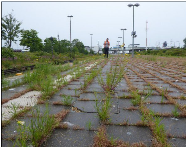
Abbildung 5: Der Bahnsteig in Puttgarden war in den Gleisabschnitten A bis C extrem verkrautet und mit Möwenkot verschmutzt.
