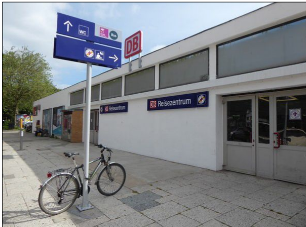
Abbildung 28: Der Eingang zum Empfangsgebäude in Elmshorn wurde in diesem Frühjahr umfangreich beschildert.
