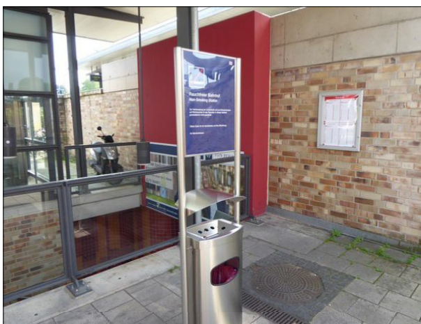
Abbildung 18: Zwei neue Abfallbehälter mit großem Aschenbecher werden am Bahnhofszugang von Reinbek gut genutzt und führten zur Verbesserung der Sauberkeit.
