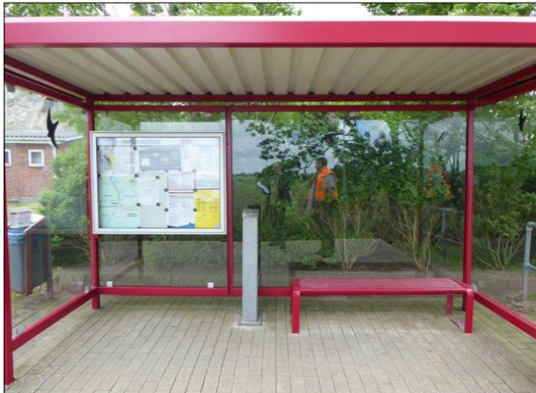
Abbildung 10: Der aufgearbeitete Wetterschutz in Maasbüll sieht wieder aus wie neu.
