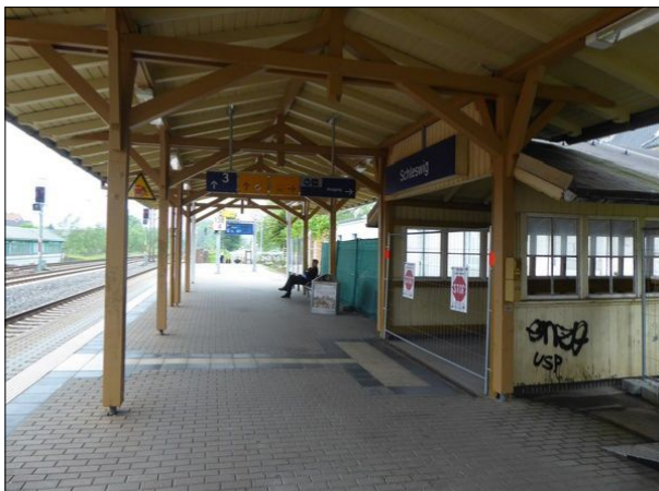
Abbildung 59: Im Zuge der Sperrung der Bahnhofshalle in Schleswig wurde auch der Laubengang versiegelt und steht vorerst nicht als Wartemöglichkeit zur Verfügung.
