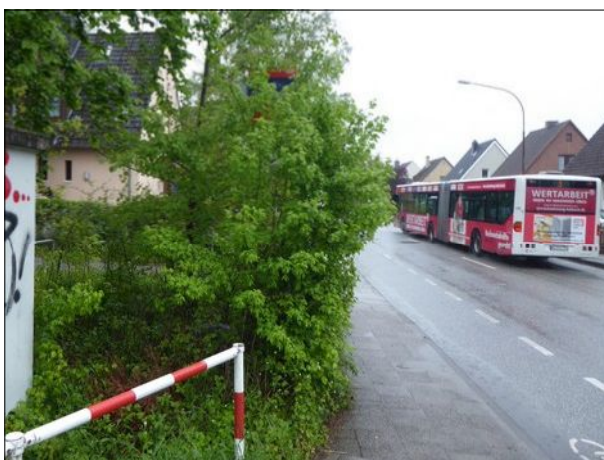
Abbildung 30: Der Stationsmast in Lübeck-St. Jürgen wurde leider nur einseitig freigeschnitten. Vom Bahnübergang aus kommend ist er weiterhin kaum zu erkennen.
