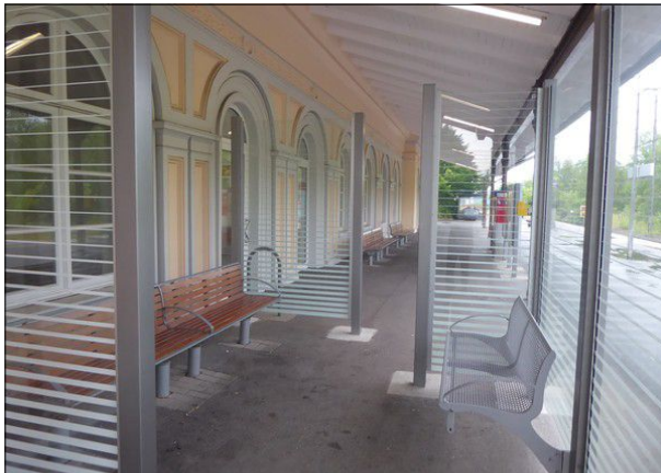
Abbildung 58: Unter dem Vordach des Bahnhofs Neustadt wurden Windschutzwände und weitere Sitzplätze installiert.
