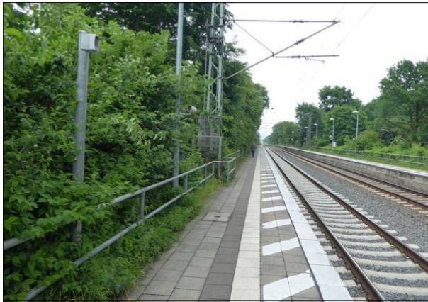
Abbildung 22: Die Uhren in Brokstedt wurde beide abgebaut. Die Masten stehen noch am Bahnsteig.
