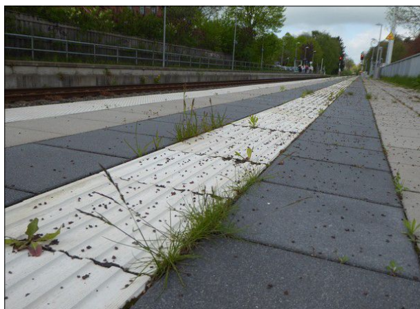
Abbildung 52: Auf ungewöhnlich vielen Bahnsteigen lagen im Mai und Juni dieses Jahres noch Streugutreste. Auch die Bahnsteige in Felde waren betroffen.
