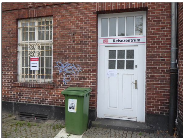
Abbildung 57: Nach der Sperrung der Empfangshalle konnte das Reisezentrum in Schleswig kurzfristig an der Straßenseite des Gebäudes eingerichtet werden.
