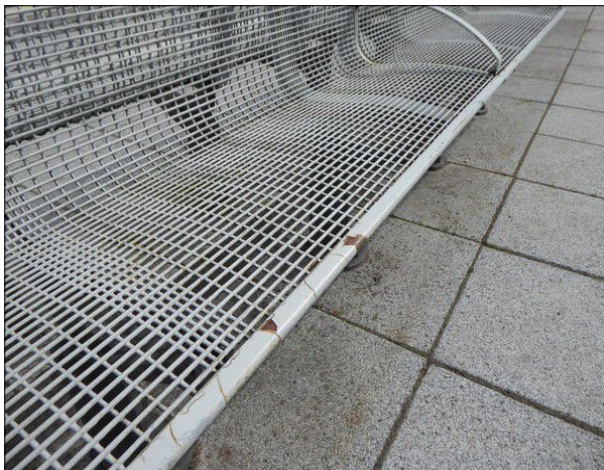
Abbildung 14: Die Roststellen an den Bänken auf dem Bahnsteig in Aumühle wurden im Jahr 2016 übergestrichen. Schon jetzt kommen die Schäden wieder zum Vorschein.
