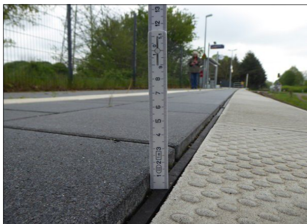
Abbildung 53: Seit der Inbetriebnahme des Bahnsteigs in Schülldorf im Januar 2015 ist die Bahnsteigkante in weiten Bereichen mehr als einen Zentimeter niedriger als der Bahnsteigplattenbelag.
