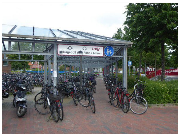
Abbildung 54: Die Durchgangsbreite des überdachten Weges zwischen dem DB- und dem NEG-Bahnhof in Niebüll wird durch abgestellte Fahrräder stark eingeschränkt.
