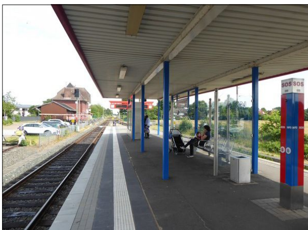
Abbildung 6: In Bönningstedt wurde an Gleis 1 im Zuge einer Bahnsteigkantenerneuerung auch ein Blindenleitstreifen eingebaut.
