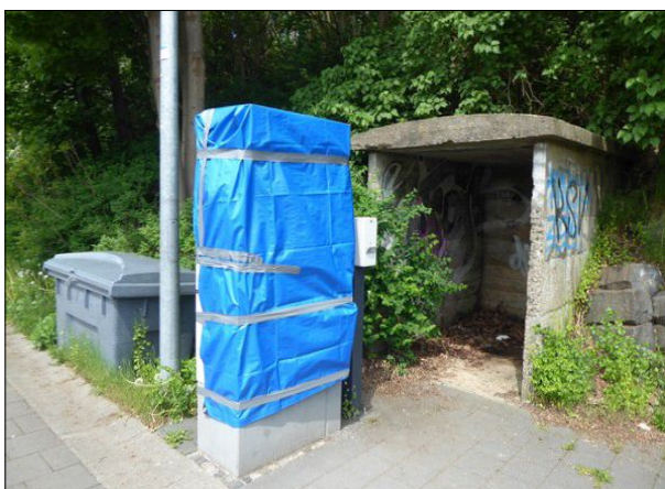
Abbildung 45: Durch einen Aufbruchversuch war der Automat in Kiel-Elmschenhagen so stark beschädigt, dass er nicht mehr nutzbar war und ausgetauscht werden musste.
