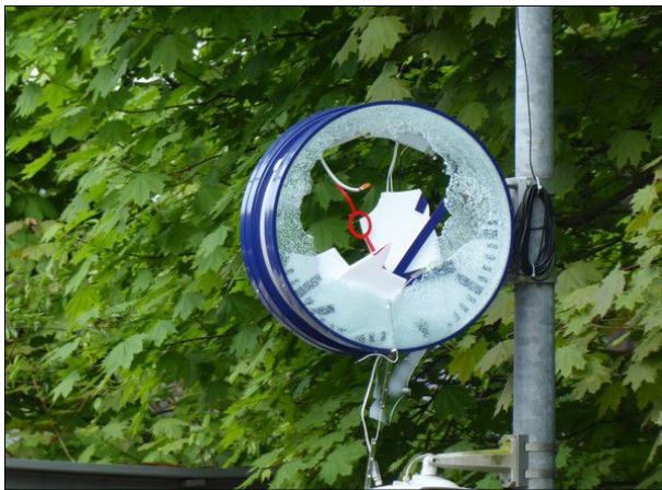
Abbildung 26: Ein frischer Vandalismusschaden wurde in Einfeld aufgenommen. Die Uhr an Gleis 1 wurde offensichtlich durch Steinwürfe zerstört.
