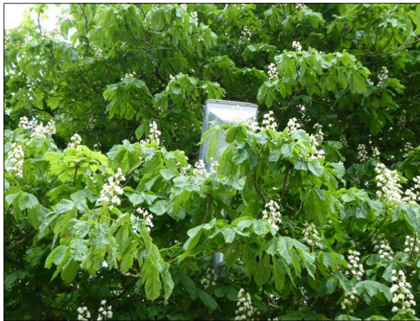
Abbildung 49: Die Leuchte im Zugang des Bahnsteigs in Wasbek war von der benachbarten Kastanie eingewachsen.
