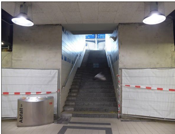
Abbildung 29: Im Zuge der Baumaßnahmen an den Tunnelwänden in Neumünster wurden die Gleisnummernschilder an den Treppenaufgängen entfernt. Die Orientierung war dadurch für die Reisenden deutlich erschwert.
