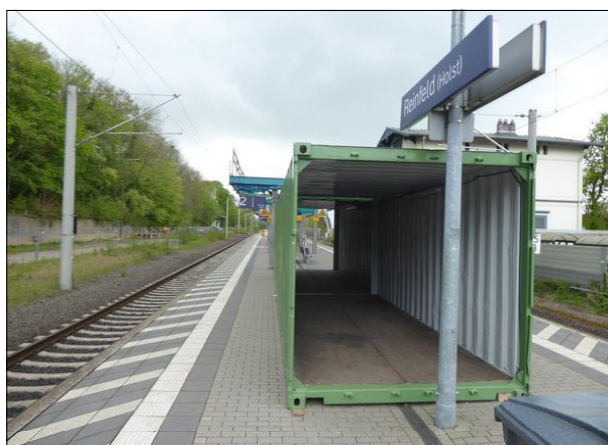
Abbildung 2: Die Eindeckung des Bahnsteigdaches in Reinfeld wurde zur Sanierung abgenommen. Provisorisch wurde ein Container als Wetterschutz aufgestellt.
